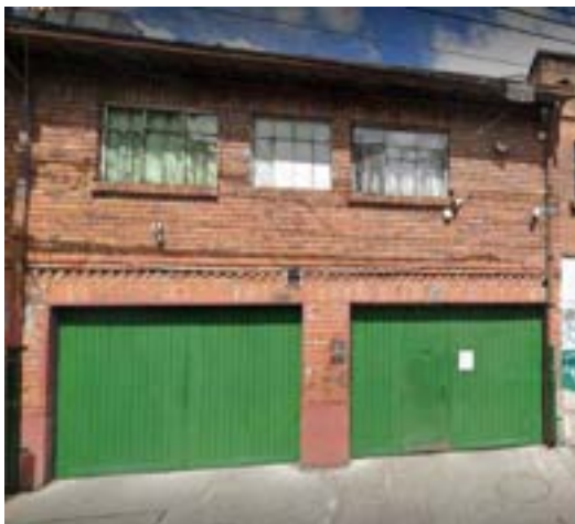
OFICINAS Y PLANTA DE PRODUCCIÓN CARRERA 72A # 70-33 BOGOTÁ. D.C COLOMBIA
